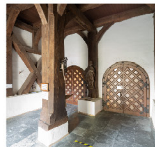
1. TURMGESCHOSS INNEN Im Mittelturm des Westwerks bronzenes Eingangsportal von Bucker und innen der Glockenstuhl von 1689.
